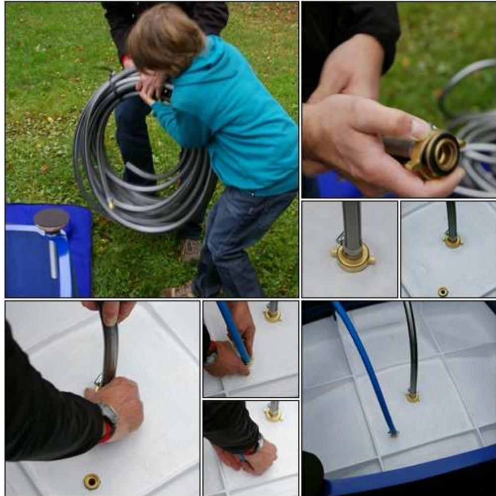
Becken mit arretierten Seitenteilen, eingesteckten Stützfüßen, und angeschlossenen Schläuchen auf Unterlage / Transporttasche über eine Seite umdrehen und aufstellen.
